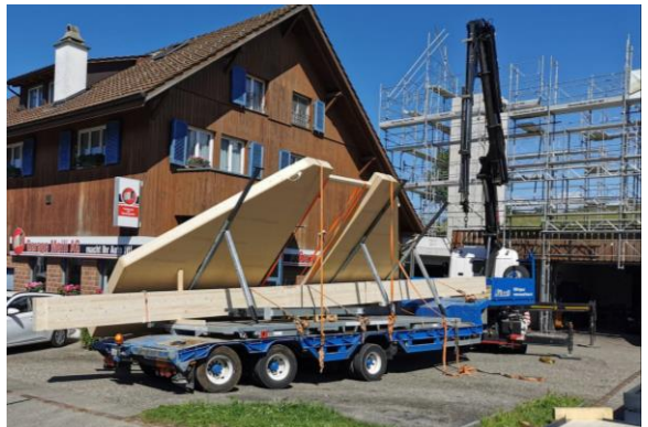
Schräglage Transportbock für Elemente bis 5 m
